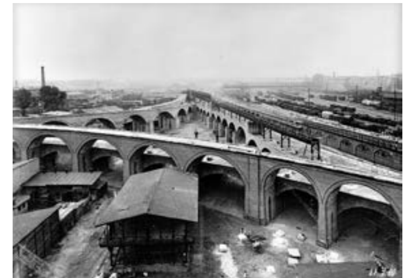
Hochbahn Gleisdreieck im Bau
