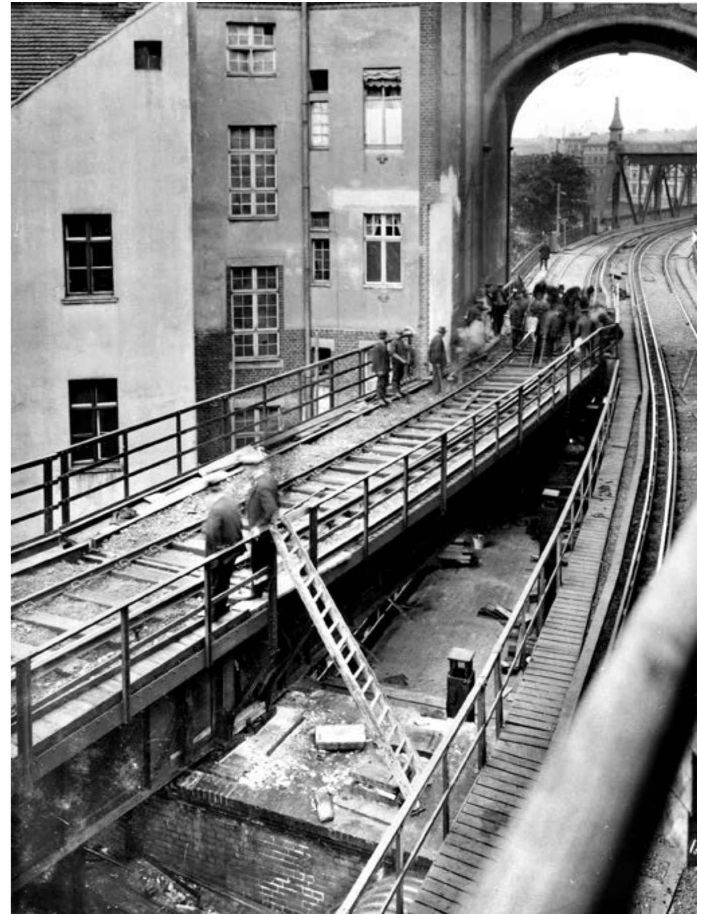
U-Bahn Gleisdreieck, Bauarbeiten an den Gleisanlagen, 1912
